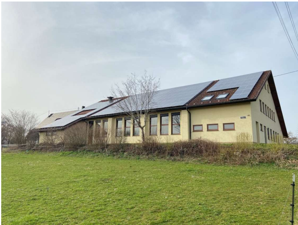
Foto 2: Ansicht der seit 20 Jahren bestehenden PV-Anlage
