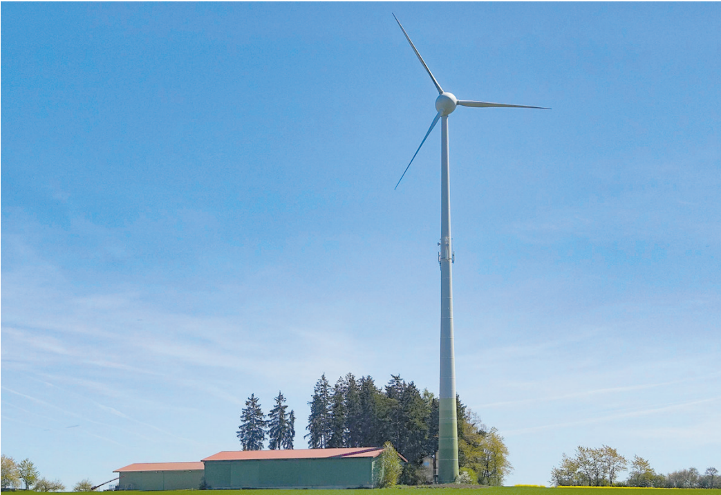
Im Sulzer Höhenstadtteil Dürrenmettstetten soll es zum Repowering vorhandener Windkraftanlagen kommen. Die Energiegenossenschaft hat die Maßnahme im Blick. Foto: Daniel Schneider
